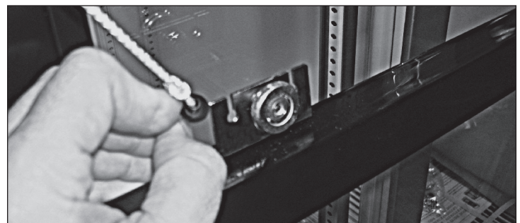
Fig. 8 Far scorrere la linguetta nera che tiene il cavo dello sportello fuori dal retro della staffa del rullo.
