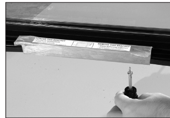
Abb. 2. Transportbügel der Glasschwingtür entfernen, falls vorhanden. Nicht wegwerfen.
