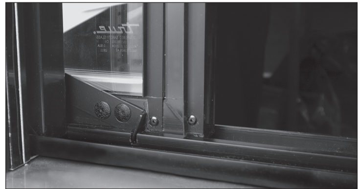
Abb. 1. Türverriegelung ist in der offenen Position (mit Kerbe eingerastet).
