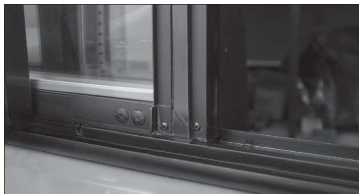
Figure 2. Le verrou de porte est en position fermée (dégagé de l'encoche).
