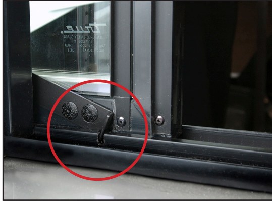
Fig. 1. El pestillo de la puerta está en posición abierta (encajado con la muesca).
