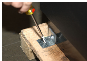
Rys. 3. Jeśli jest obecny, zdjąć wspornik L.
