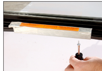
Abb. 2 Die Transportsicherung bei Schwenktüren aus Glas entfernen, sofern vorhanden. Die Sicherungen nicht entsorgen.
