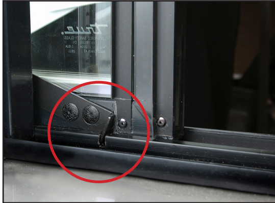
Abb. 1 Feststellriegel geöffnet (in Nocke eingerastet)
