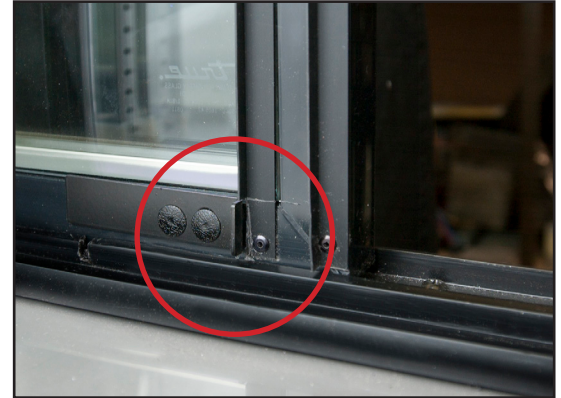
Abb. 2 Feststellriegel geschlossen (nicht in Nocke eingerastet)
