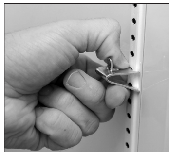
Fig. 8. Es posible que tenga que presionar o girar la parte inferior del elemento de fijación para instalarlo.
