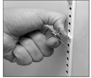
Şekil 2. Raf klipsinin alt tırnağı sıkıca oturacaktır.
