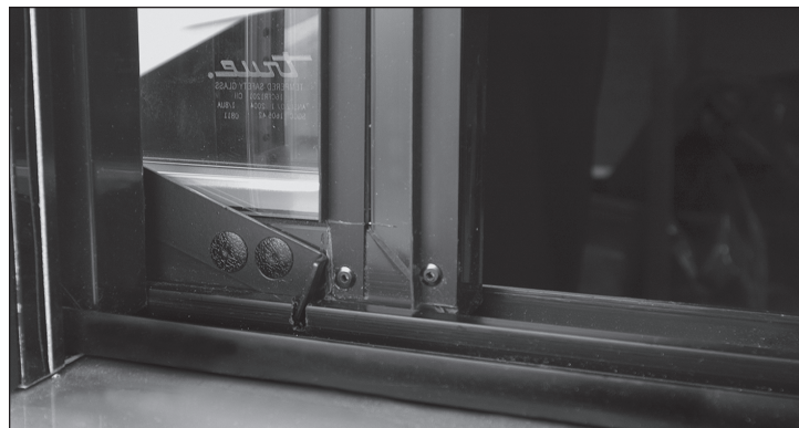
Fig. 1. El pestillo de la puerta está en posición abierta (encajado con la muesca).
