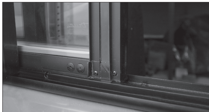
Fig. 2. El pestillo de la puerta está en posición cerrada (desenganchado de la muesca).
