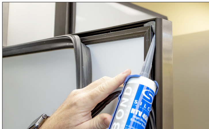
Rys. 3. Nałożyć silikon na każdy róg kanału uszczelki.
