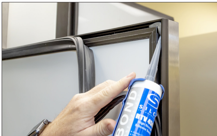
Fig. 3. Applicare il silicone su ogni angolo del canale della guarnizione.
