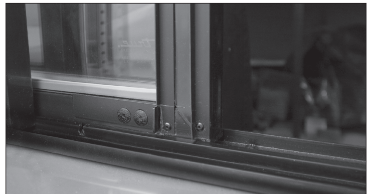
Abb. 2. Feststellriegel geschlossen (nicht in Nocke eingerastet)
