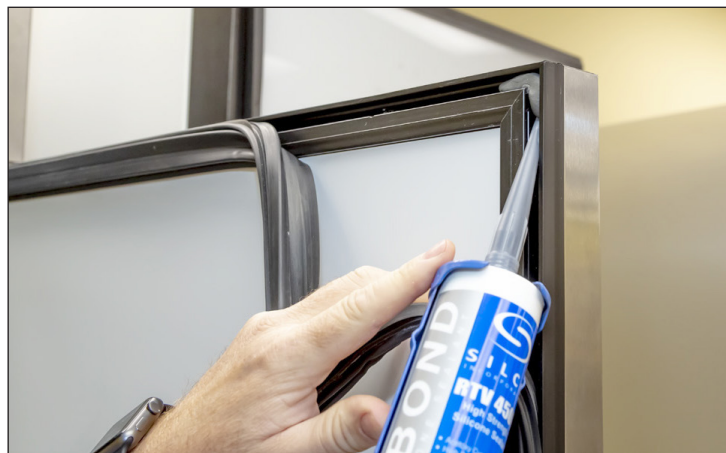
Abb. 3. Der Dichtungskanal wird in allen Ecken mit Silikon versehen.
