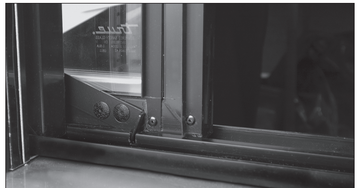
Abb. 1. Feststellriegel geöffnet (in Nocke eingerastet)
