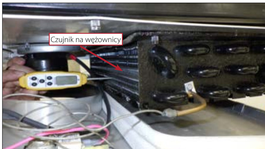
Rys. 1. W przypadku regulatorów mierzących temperaturę w wężownicy, sprawdzać temperaturę wężownicy jak najbliższej znajdującego się w niej czujnika.
