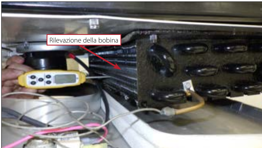
Fig. 1 Per i dispositivi di controllo di rilevamento della bobina, controllare la temperatura della bobina il più vicino possibile al sensore all'interno della bobina dell'evaporatore.
