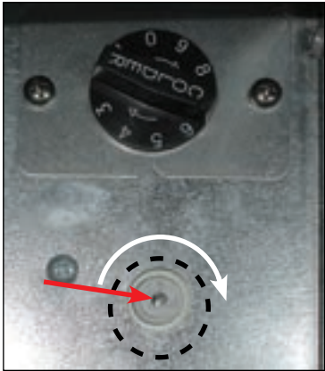
Figure 2. Tournez le pignon de commande en sens horaire jusqu'au déclié des contacts.
