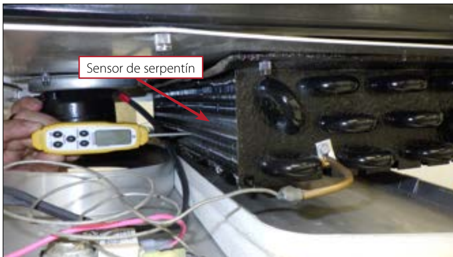
Fig. 1. Para los controles con sensor de serpentín, verifique la temperatura del serpentín lo más cerca posible del sensor dentro del serpentín del evaporador.
