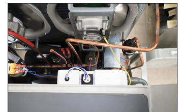
Afb. 2. Bovenaanzicht TRUEZONE uv-systeem.
