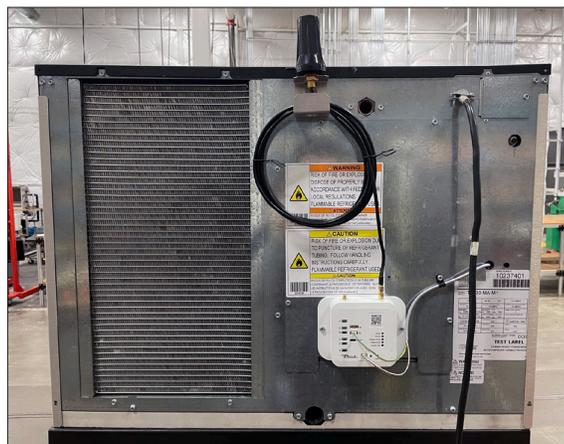
**Fig. 3** Antenna installata sul modem. L'antenna può variare.
