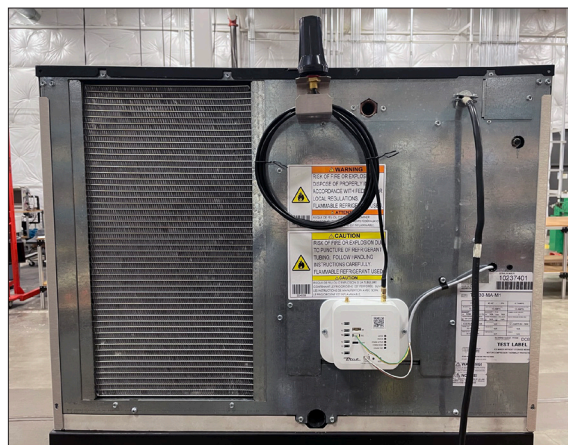
Abb. 3. Am Modem installierte Antenne. Ihre Antenne kann sich unterscheiden.
