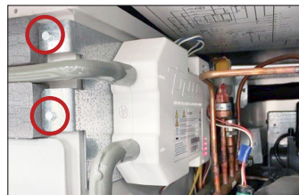
الشكل 3، عرض جانبي لنظام TRUEZONE للأشعة فوق البنفسجية. أماكن براغي حامل TRUEZONE.
