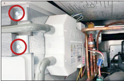
Fig. 3. Vue latérale du système UV TRUEZONE. Emplacements des vis du support TRUEZONE.
