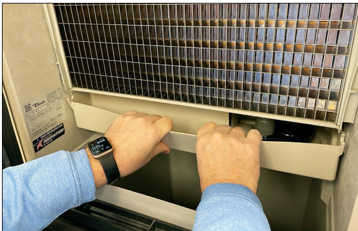
Fig. 4. Tirez le réservoir de récupération vers l'avant et poussez vers le bas.
