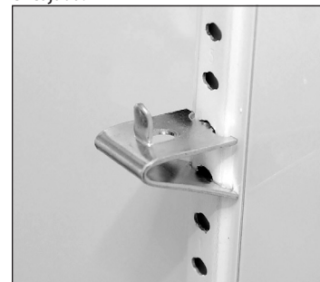
Fig. 4. Elemento de fijación de estante instalado.
