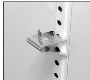
Fig. 4. Clip d'étagère installé.
