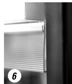
6 Profilé en U de l'écran protecteur mis en place sur le support métallique.
