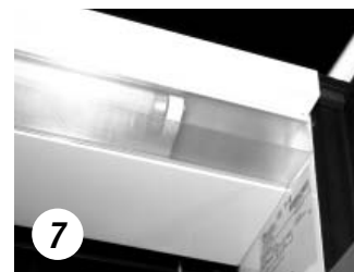
7 Goed geïnstalleerde bovenste lampconstructie.
