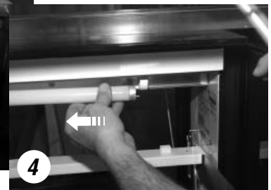
4 Lamp verwijderen door lamp voorzichtig in veergeladen lamphouder te duwen.
